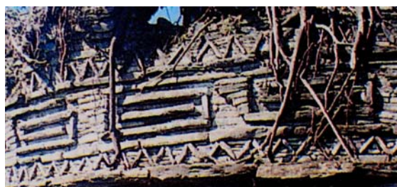
Figura 41: Detalle en muro de un edificio circular de Pajatén, relieve en piedra con el motivo de fertilidad.
