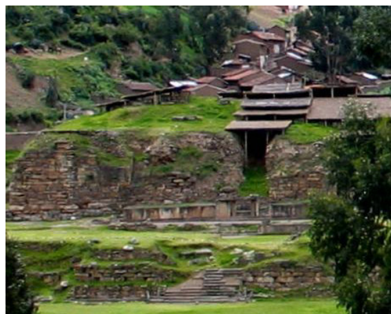
Imagen 15: vista desde el oeste al Templo Nuevo de Chavín parcialmente derruido.
